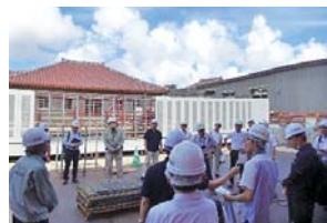
「首里城復元工事」
